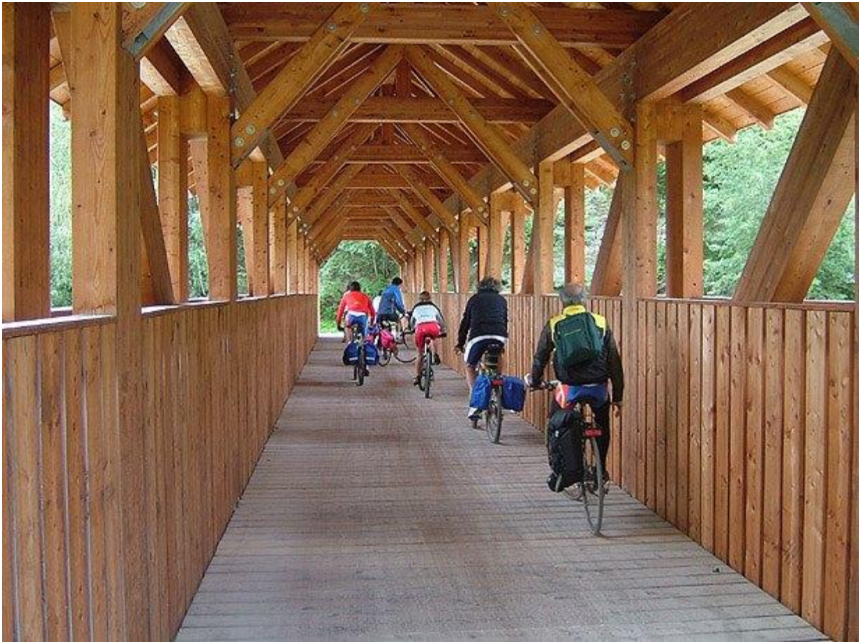
Foto 2: esempio di ponte ciclo-pedonale sopraelevato
